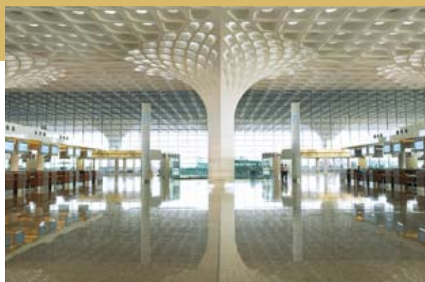
1. ábra A mumbai repülőtér-terminál látszó teherhordó szerkezete algoritmikus tervezési munkamódszerrel készült: a szerkezetet a hagyományos indiai formavilágot igyekszik modern eszközökkel visszaadni
