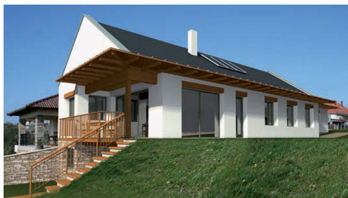
2. ábra. Családi ház, Ajkarendek, építész: Major Attila, BioÉpítés Kft. Hazánk első ökológikus vályog passzívháza
