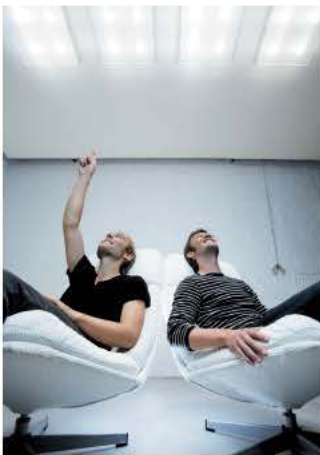
5. ábra. A hybrid-szolár rendszer lámpatestjei természetes fényt sugároznak (Parans Solar Lighting R&D, Svédország)
